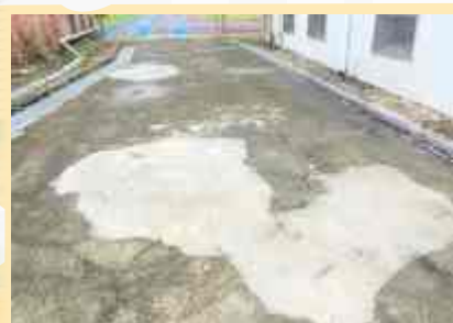
水泥路面補修
