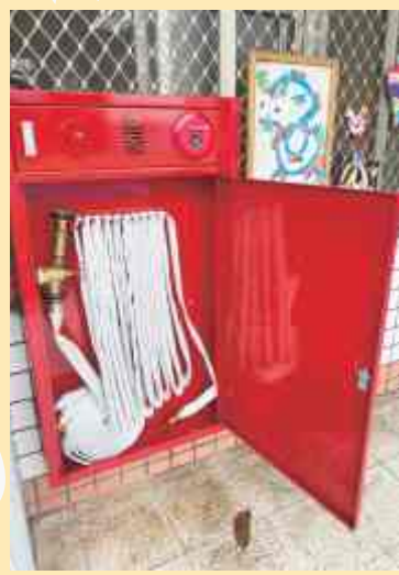
消防設備更換
