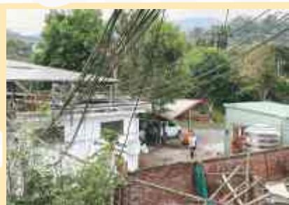
車棚天溝槽清淤
