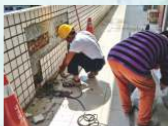
二樓洗手台拆除
