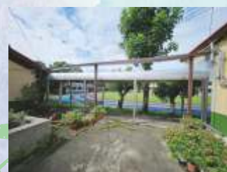
風雨走廊建置 (專科教室至倉庫段)
